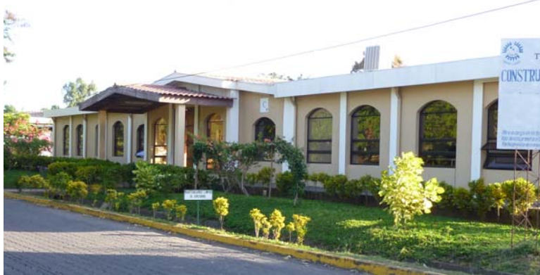
CISTA (Centro de Investigacion de Salud, Trabajo y Ambiente) som byggts upp genom medel från olika källor där solidaritetsgrupper från Spanien och Italien varit särskilt aktiva
